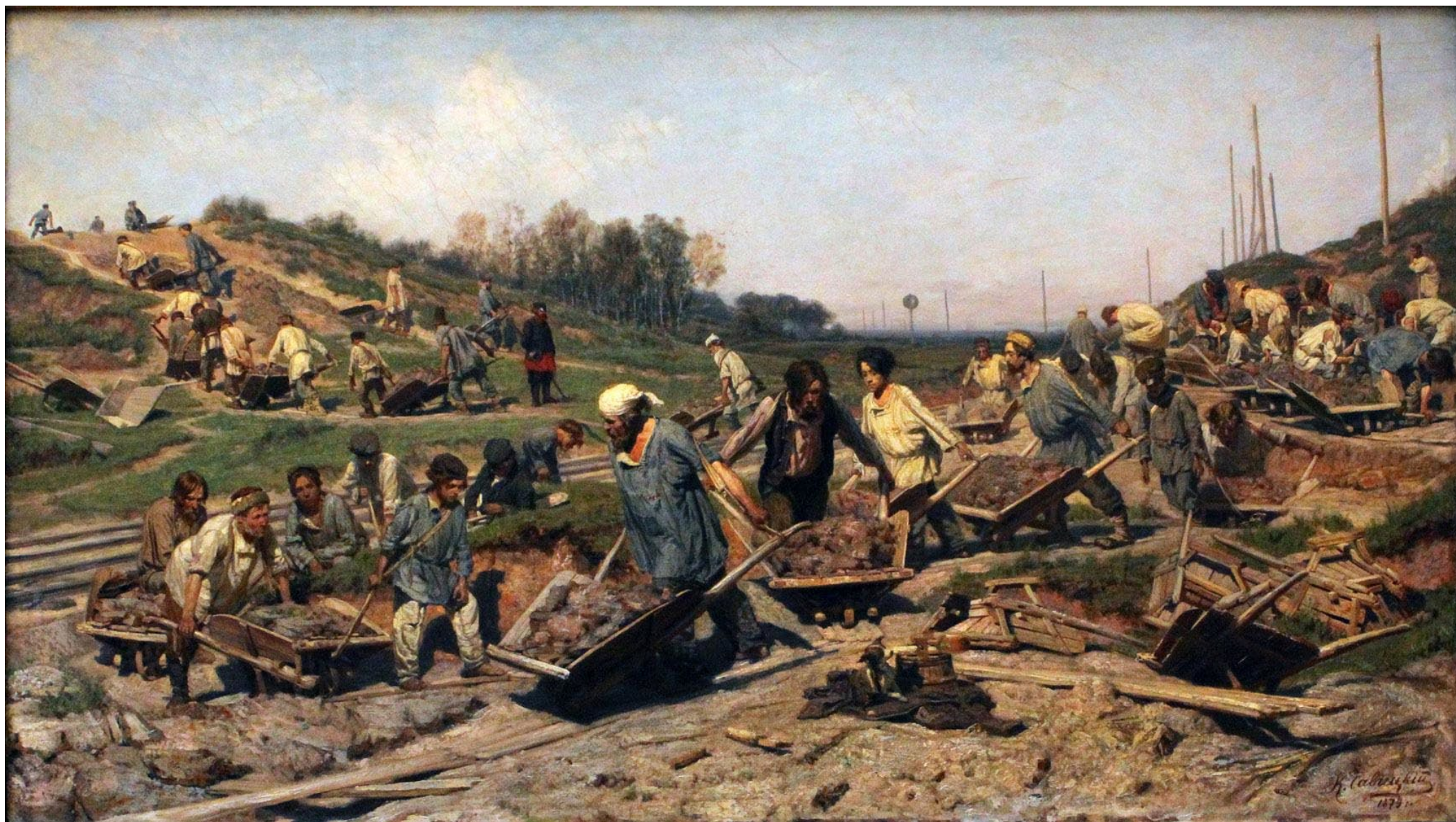
К.Савицкий «Ремонтные работы на железной дороге»
